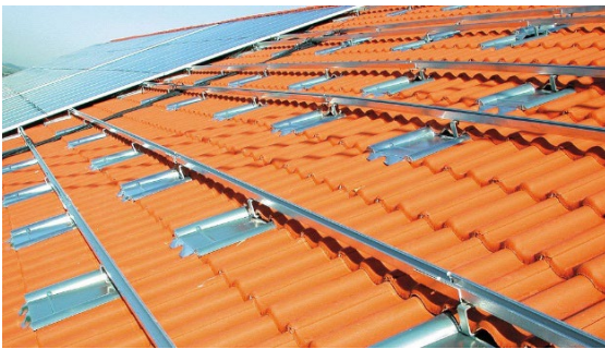
Befestigung von Dachhaken an den Sparren - Blechziegel 4
