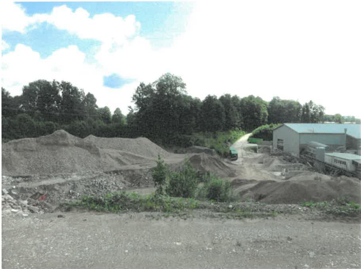
Abb. 4: Deponie im Nordwesten des B-Plangebietes
