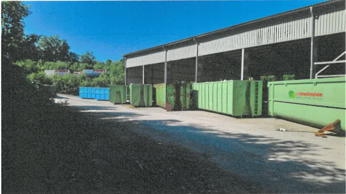
Abb. 3: Der Bauschuttsortieranlage vorgelagerte Halle
